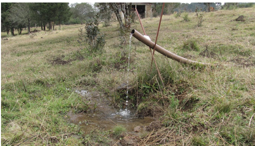
Figura 16 - Dreno do açude que abastece o banhado.
