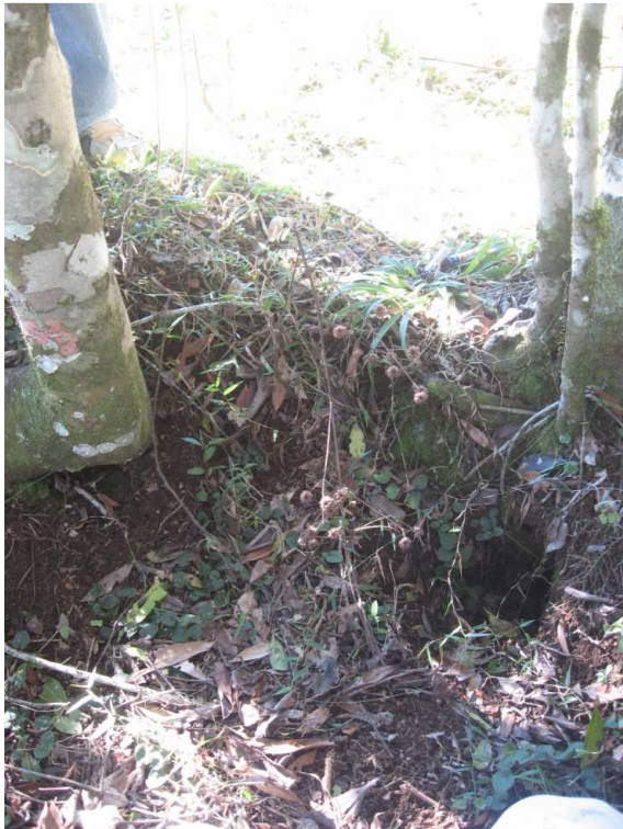
Figura 2 - Estrutura de abatimento associada com subsidência do solo. Foto: Autor, encosta do Rio das Pombas, 09/05/2007.
