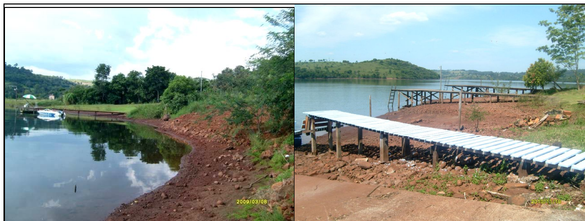
FIGURA 18: Nível da água no reservatório
