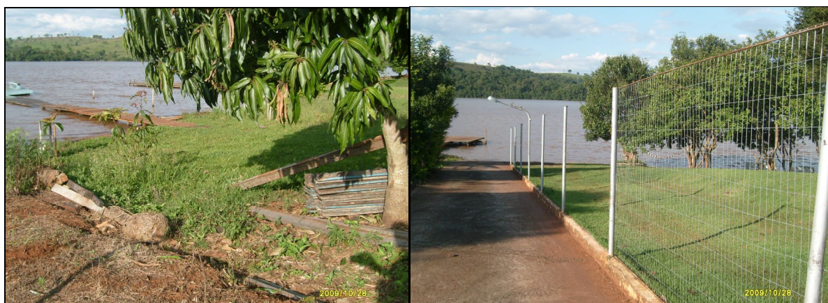
FIGURA 17: Cercas e muros delimitadores de lotes na margem do reservatório
