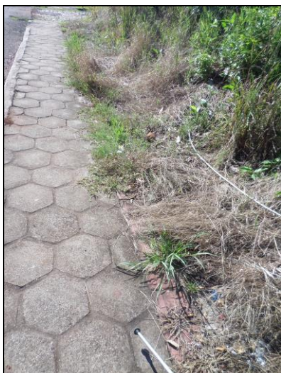
Figura 23 - Bengala próximo ao piso tátil que está coberto pelo mato. Foto: TIBOLA, Maiara. 2015.
