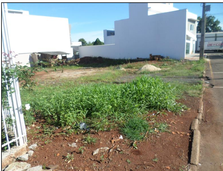
Figura 21 - Terra, grama e pedra no local onde deveria existir calçada.
