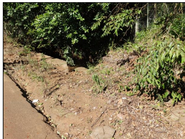
Figura 27 - Local próximo ao afluente do rio Urutago, sem calçada e sem proteção. Foto: TIBOLA, Maiara. 2015.
