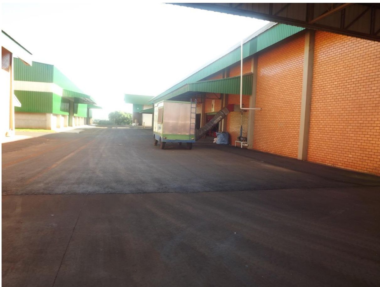
FIGURA 15: Climatizador/ar condicionado de Sementes Para UBS (Bocchi Agronegócios).
