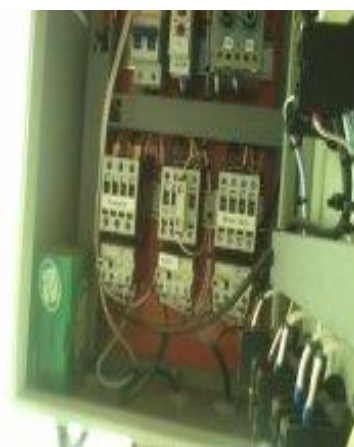
Foto 4: Painel de controle automático da máquina de queima do pellets. Fonte: Pesquisa de campo na propriedade de H. H., Outubro/2013.
